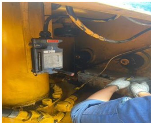
Gambar 12. Pencopotan Battery Hydraulic Sumber: Dokumentasi Pribadi (2024)
