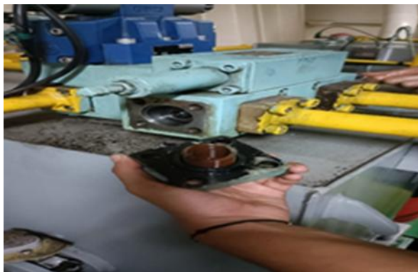
Gambar 3. Pembongkaran awal solenoid actuator
