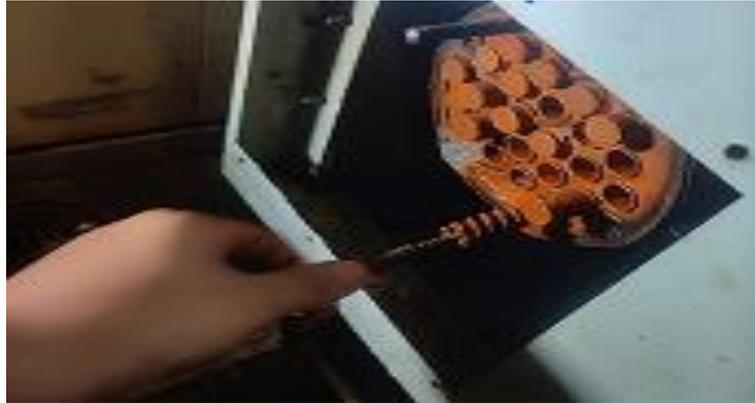
**Gambar 4.** Pembersihan kotoran di pipa kondensor
