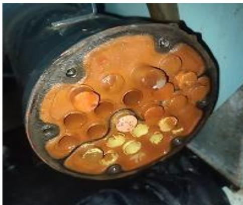
**Gambar 3.** Endapan pada pipa kondensor
