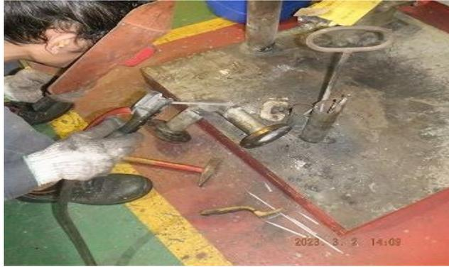
**Gambar 6.** Pengelasan sambungan pipa
