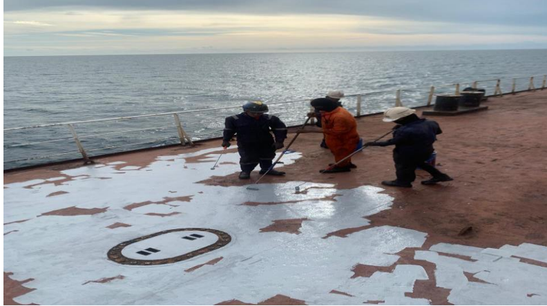
Gambar 1. Pelapisan dengan Cat Primer Sumber: Dokumen Pribadi
